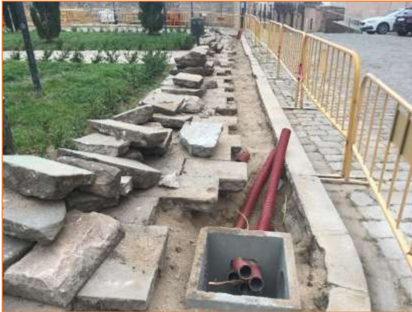
Foto 29. Vista de la plaça del Monestir després de la col·locació dels tubs.
