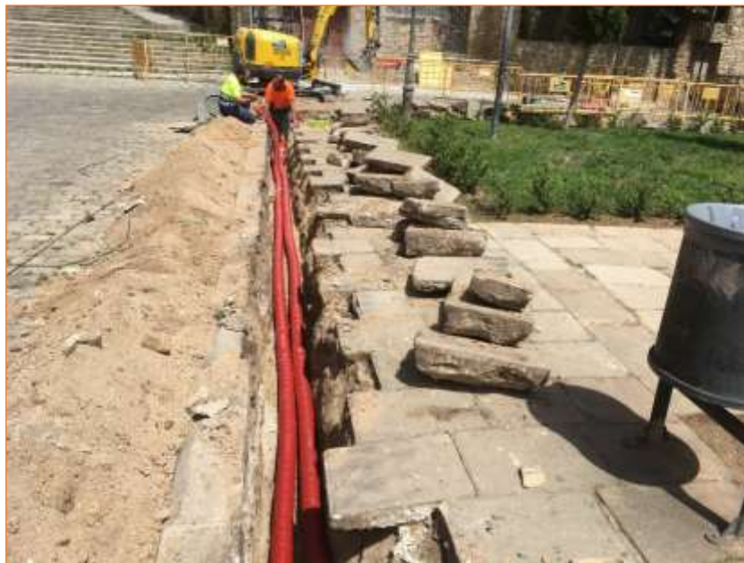
Foto 28. Vista de la plaça del Monestir després de la col·locació dels tubs.
