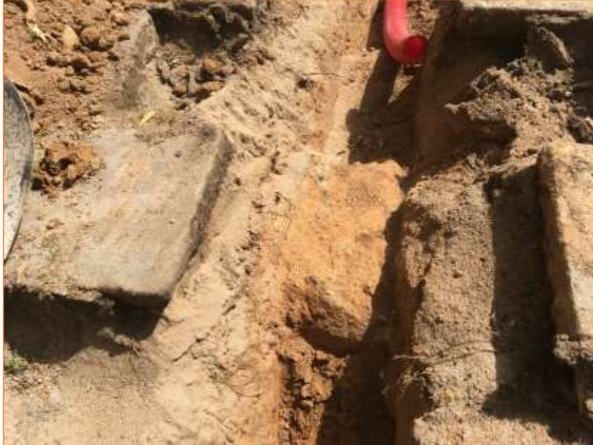
Foto 21. Vista del mur UE 15 al moment de la seva descoberta.
