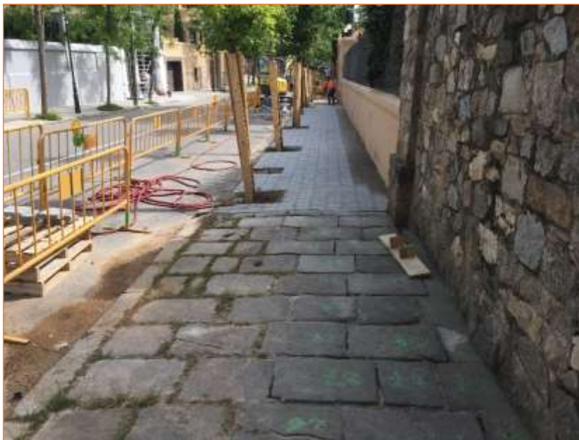
Foto 12. Vista de la rasa del c. Monestir després de la finalització dels treballs.
