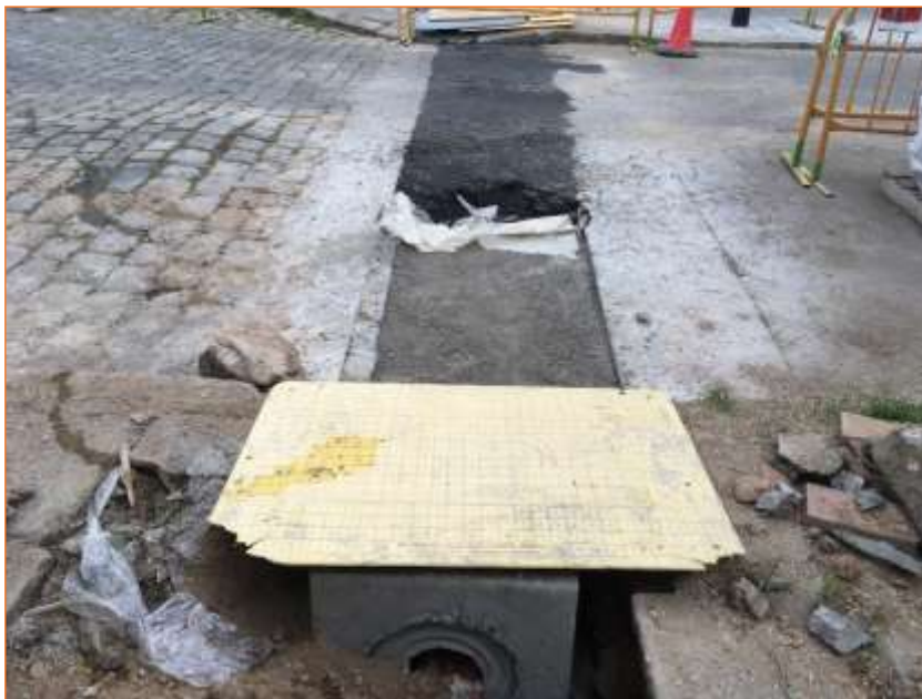
Foto 18. Vista del creuament de carrer després de les obres.
