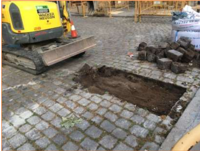
Foto 25. Vista de les obres de creuament a la plaça del Monestir.
