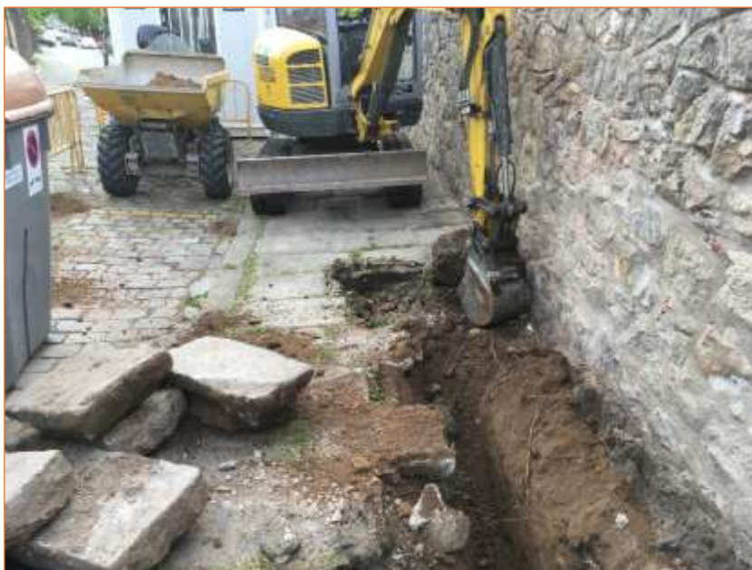
Foto 6. Vista de l'inici dels treballs a la rasa del carrer del Monestir.
