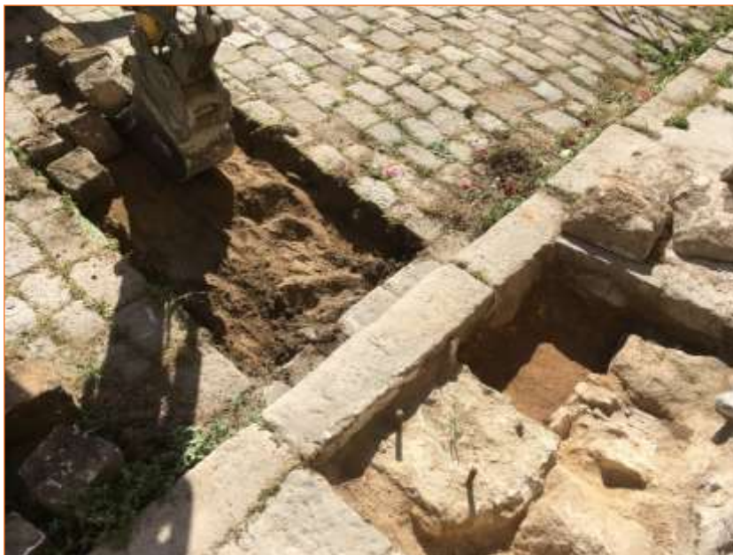
Foto 30. Vista de l'inici dels treballs del creuament a la plaça del Monestir.
