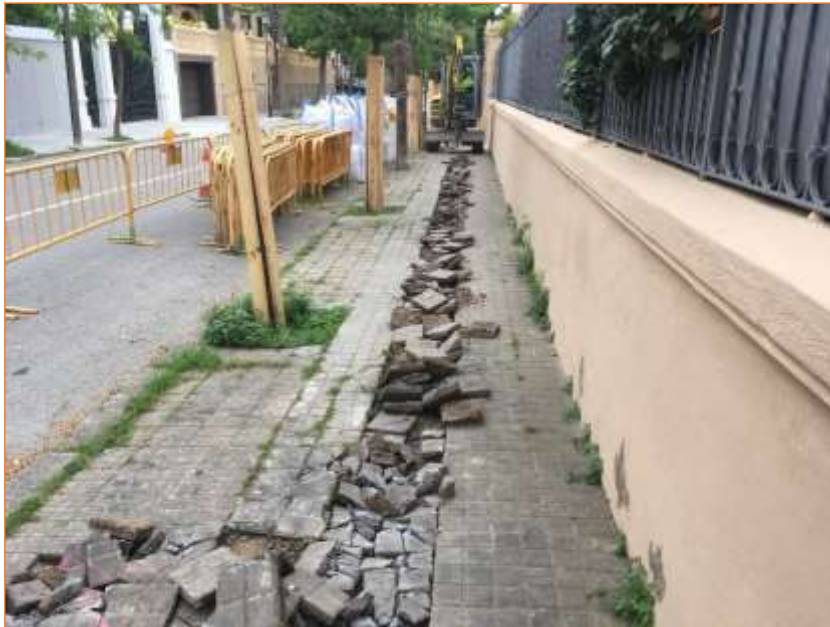
Foto 10. Vista de la rasa del c. Monestir, zona dels panots, inici de les obres.
