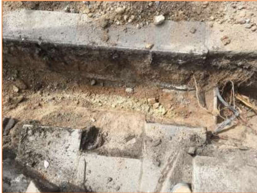
Foto 27. Vista de l'estratigrafia a la plaça UE 1 i UE 14.
