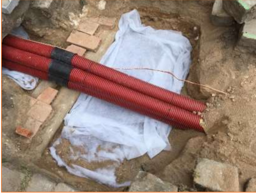
Foto 35. Vista de les UE 22 i UE 25 després de col·locar els tubs de PVC.
