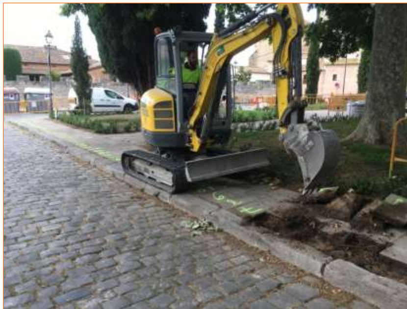
Foto 26. Vista de l'inici d'obres en les rases perimetrals a la pl del Monestir.
