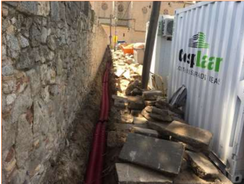
Foto 7. Vista de la rasa del c. Monestir després de la col·locació dels tubs.
