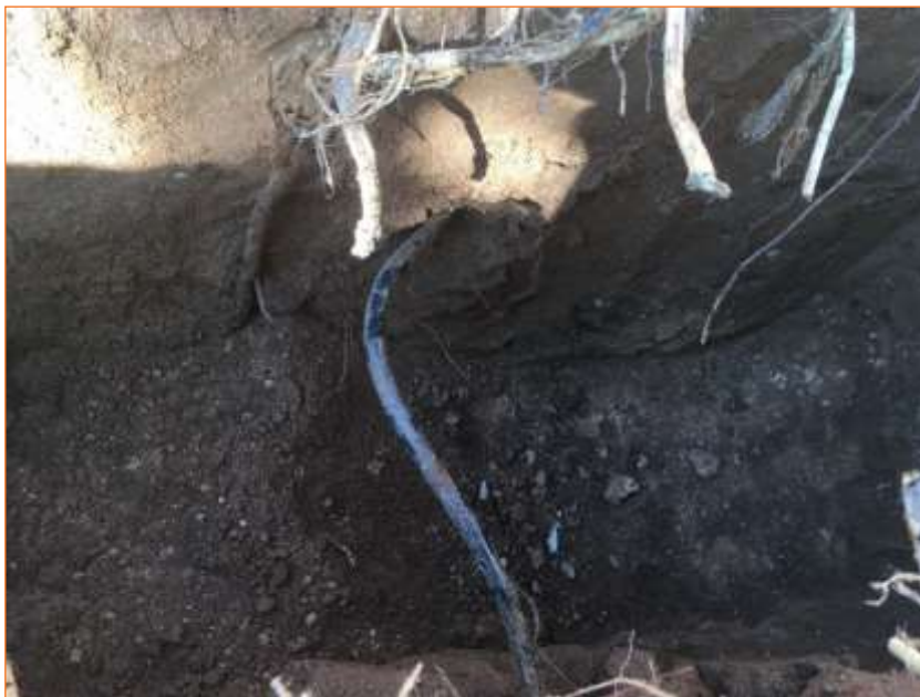
Foto 4. Vista de la cala 3 després de la realització dels treballs.
