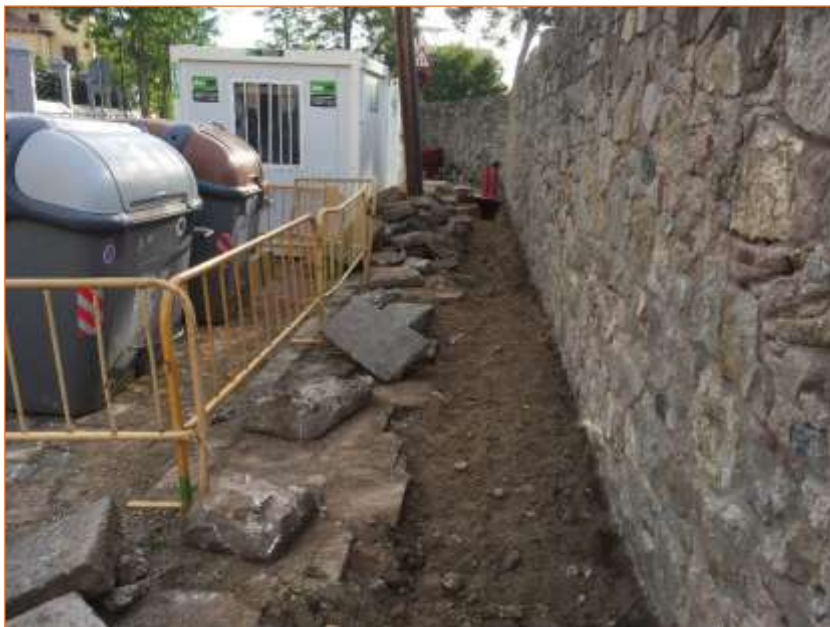
Foto 8. Vista de la rasa del c. Monestir després de tapar amb terra la rasa.
