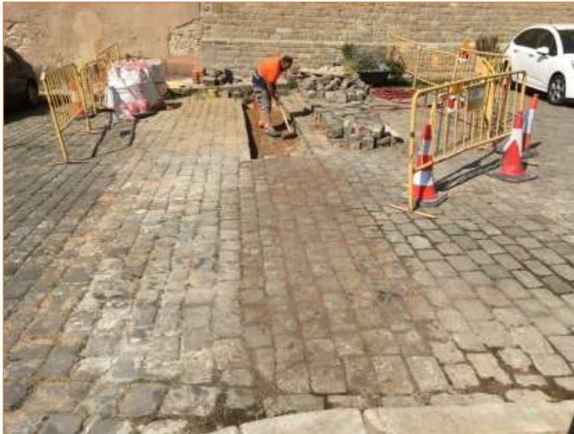
Foto 36. Vista de la col·locació de les llambordes a la rasa de creuament.
