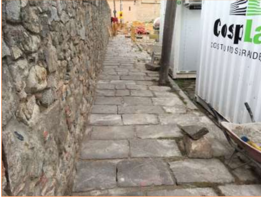
Foto 9. Vista de la rasa del c. Monestir després d'acabar les obres.
