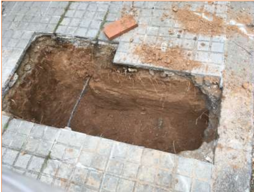
Foto 5. Vista de la cala 4 després de la realització dels treballs.
