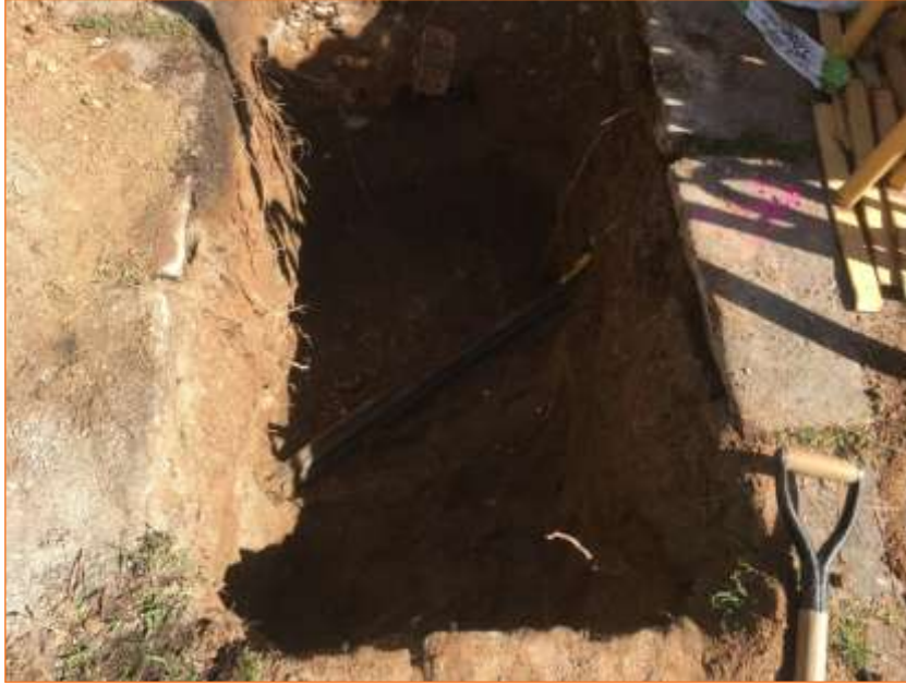
Foto 3. Vista de la cala 2 després de la realització dels treballs.
